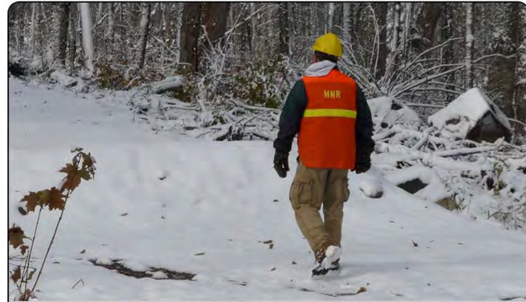
Inspection de l'enlèvement d'un ponceau
