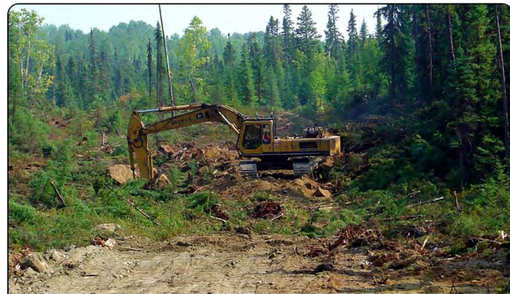
Construction d'une route
