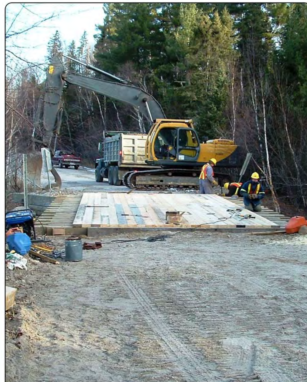
Construction d'un pont
