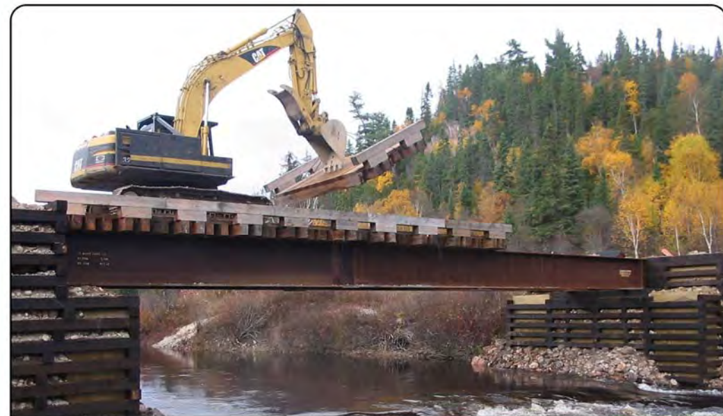
Construction d'un pont
