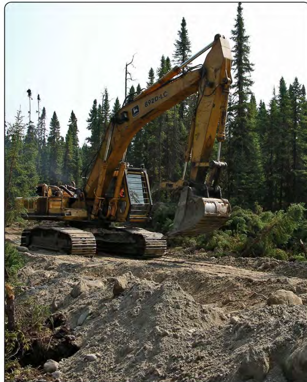
Construction d'une route
